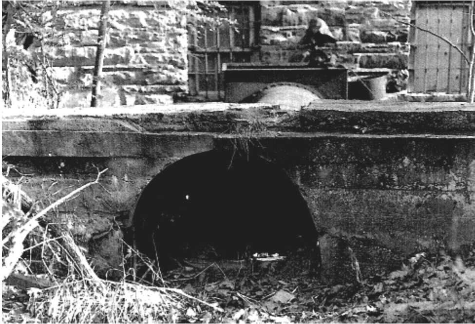
Fig. 20. Forebay. Photo, Nov. 1980.
